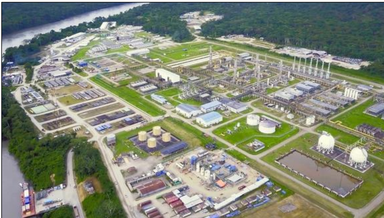
Gas de Camisea en la Planta Malvinas (distrito Megantoni, provincia La Convención, Cusco). Fuente: elgasnoticias.com
