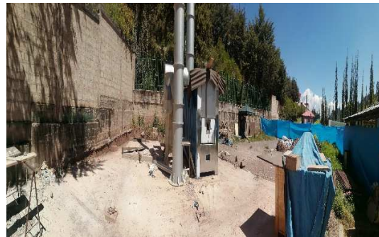
Vista panorámica construcción Crematorio
